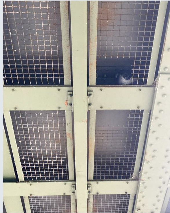
Offene Gitterplatten unter einer Brücke
