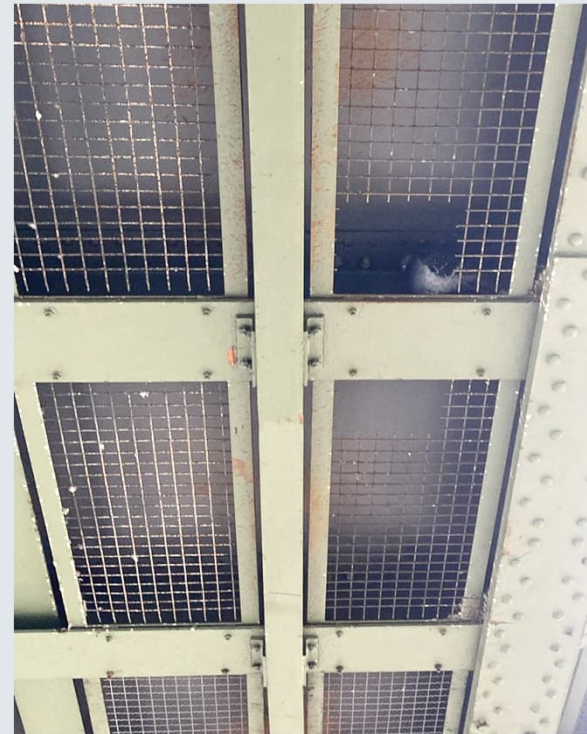
Offene Gitterplatten unter einer Brücke
